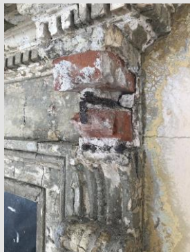
Fassaden- sanierung (Königstraße)
