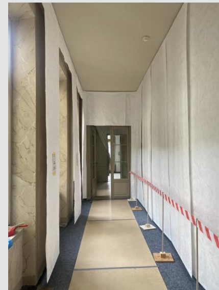
Schutzmaßnahmen im Zuge der Fenstersanierung
