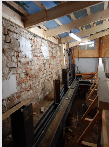
Einbau eines Aufzuges (Innenhof)
